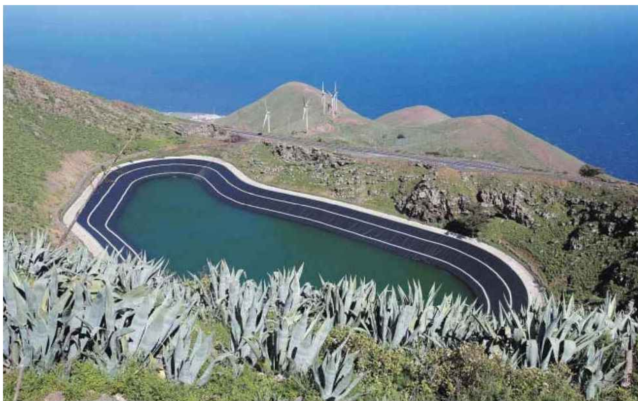
Vue sur le parc d'éoliennes associé à un « Step », sur l'île del Hierro, aux Canaries. Cette station de transfert d'énergie par pompage permet de stocker l'eau dans un grand bassin à 700 mètres au-dessus du niveau de la mer. DESIRÉE MARTIN/AFP
