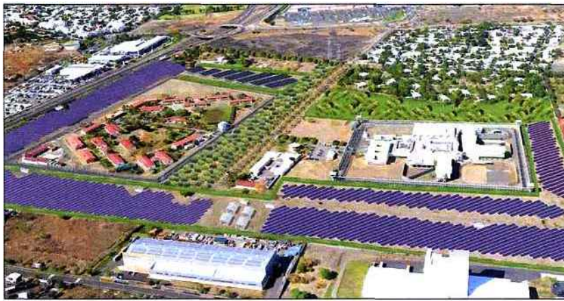
Le projet de centrale solaire autour de la prison du Port par Akuo Energy comprend un gros volet réinsertion pour les détenus.
