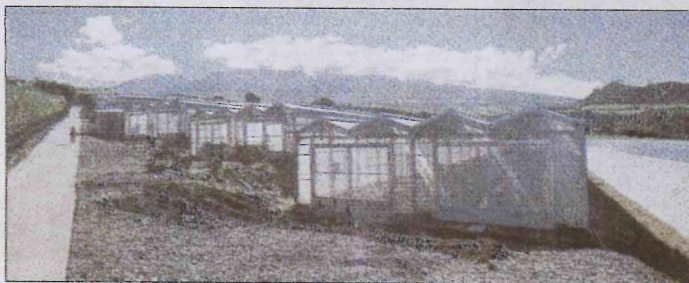
Les 14 200 m 2 de serres photovoltaïques permettent de produire 1,4 MW. (Photo Yann Huet)
