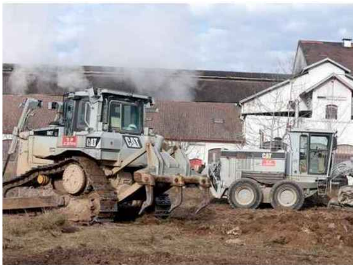
Le coup d'envoi du chantier de la centrale, qui durera deux ans et mobilisera 120 personnes. Photo Ludovic LAUDE
