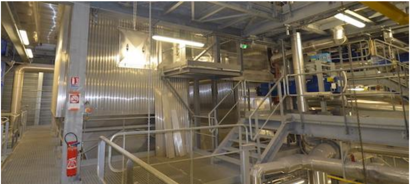
L'économiseur avec en bleu le système de ramonage à la vapeur, photo Frédéric Douard
