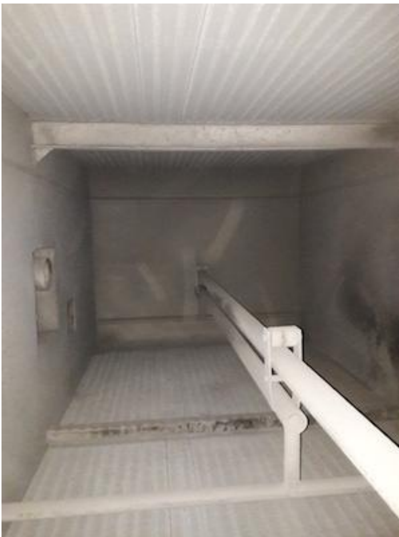
Arrière de l'économiseur avec buses de sortie EG10XL, photo Explosion Power
