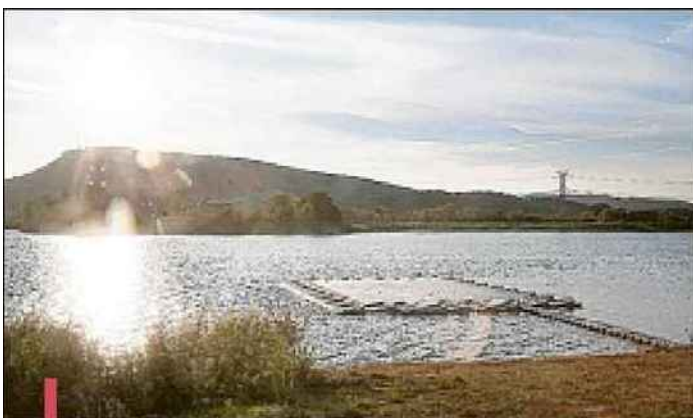
Un prototype des caissons flottants équipés de panneaux photovoltaïques a été présenté en septembre dernier. /PHOTO B.S.
