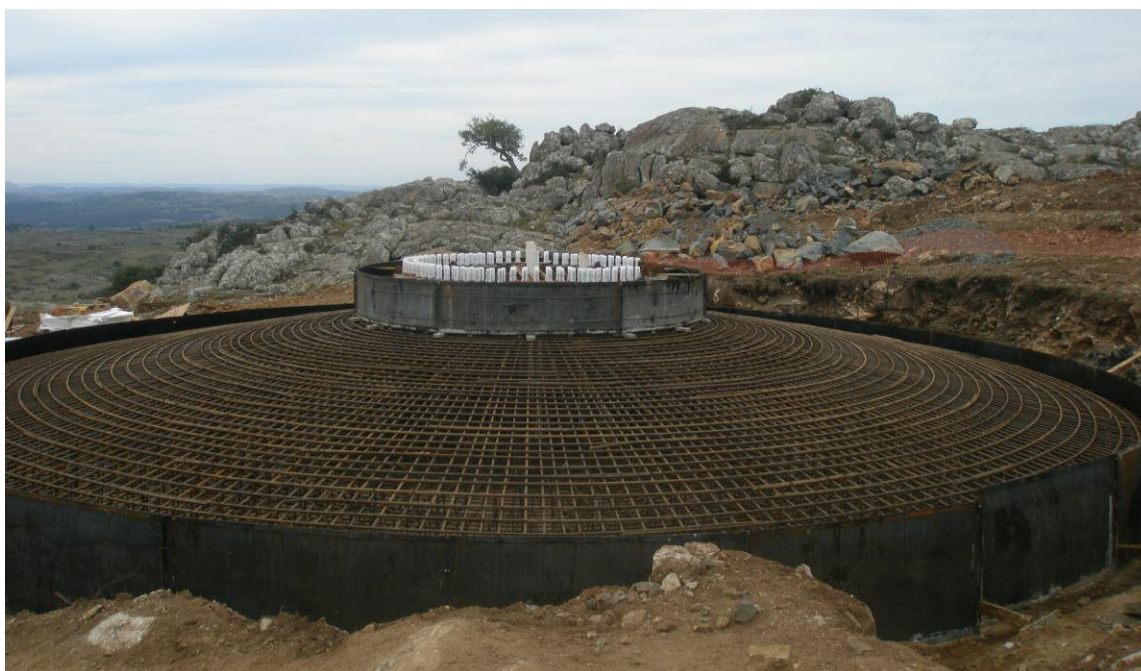
Fondations d'une éolienne du parc Minas, Uruguay
