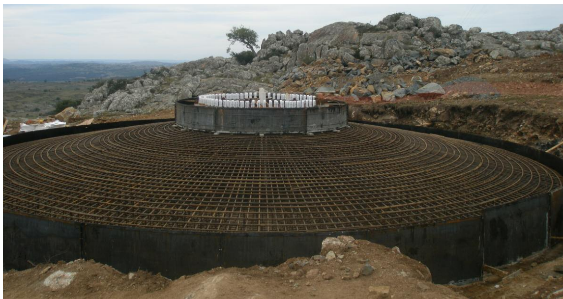
Fondations d'une éolienne du parc Minas, Uruguay
