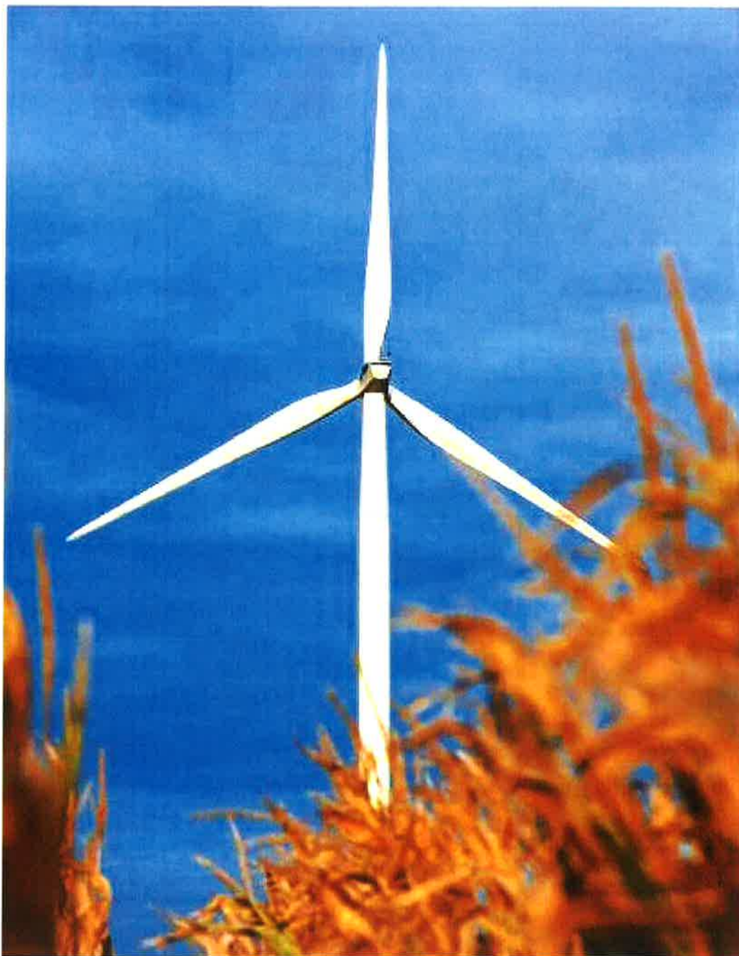
La première pierre du vaste projet éolien de Rocksprings, au Texas, a été posée il y a quelques jours. Le parc devrait fonctionner à partir de la mi-2015 et sa capacité de production sera à terme de 200 mégawatts. Photo Simon Lourtee/Akuo Energy
