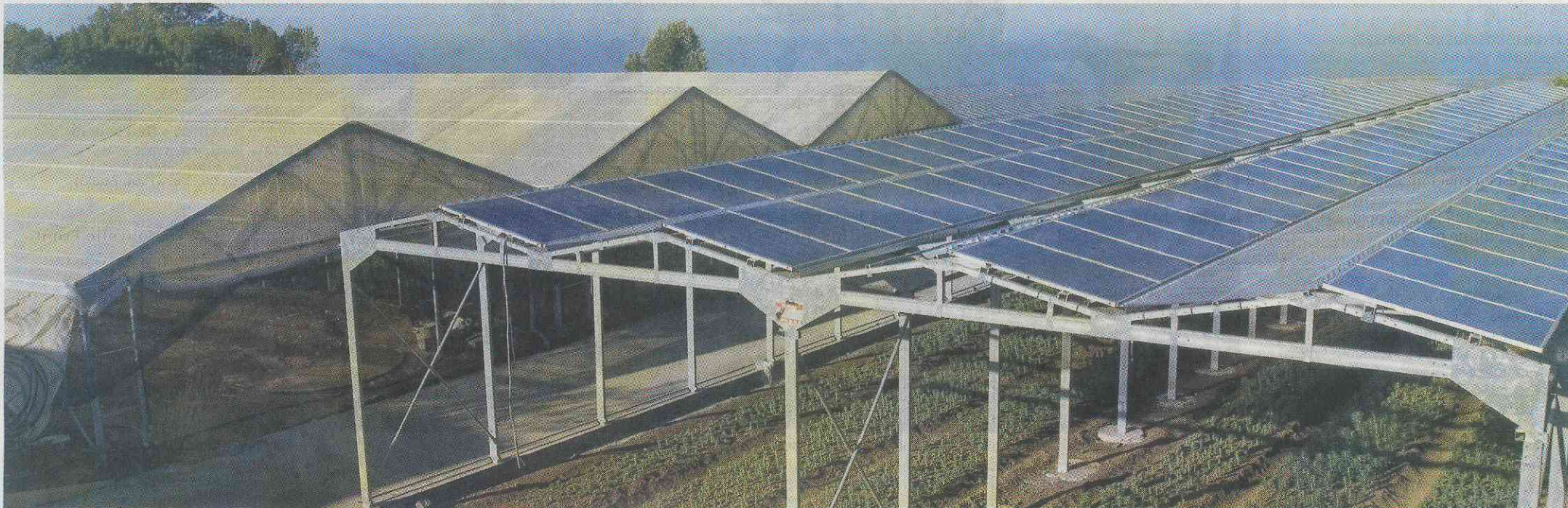
Située dans le sud-ouest de l'île, cette centrale photovoltaïque de troisième génération abrite une plantation de lys et d'anthuriums et comprend un système de récupération d'eau de pluie.
