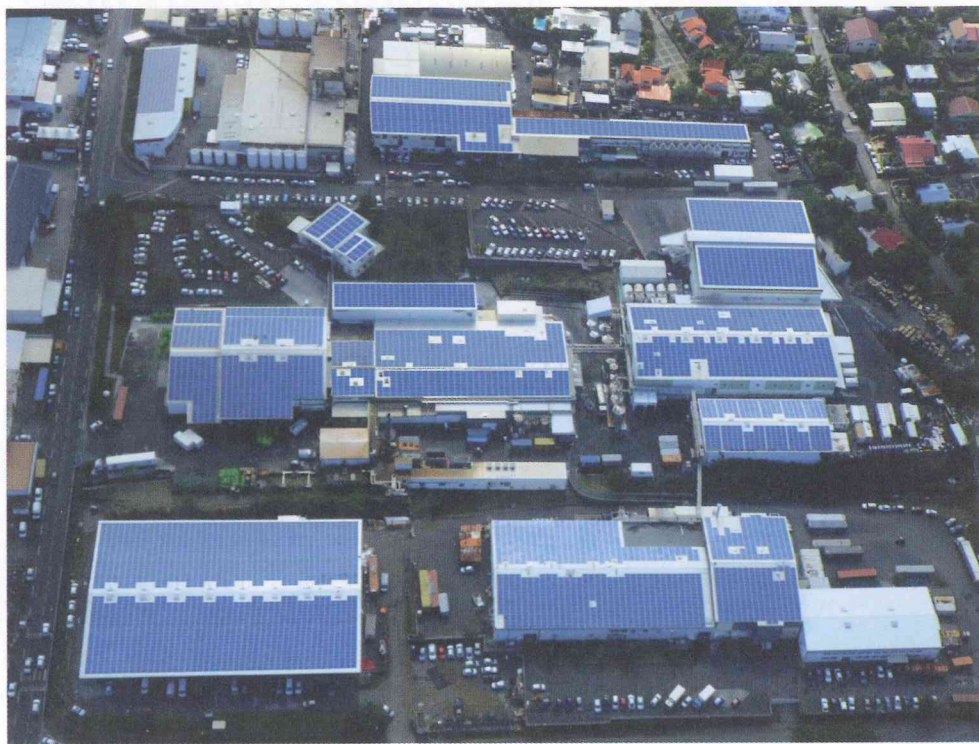
Les toits de l'usine de la CILAM, à Saint-Pierre, sont recouverts de 10 600 panneaux photovoltaïques. De quoi fournir de l'électricité à 1 130 familles (avec une production annuelle de 2 751 Mwh). Il s'agit d'ailleurs de l'une des plus grandes centrales photovoltaïques de France.
