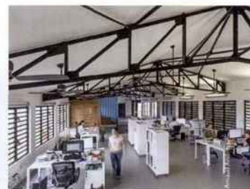
Les jalousies régulent le flux d'air et permettent de ventiler la nuit.
