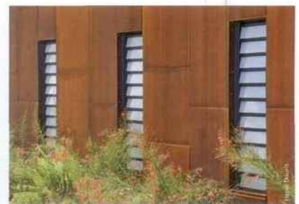
L'acier autopatinable du local de stockage contraste avec le reste du bâtiment.
