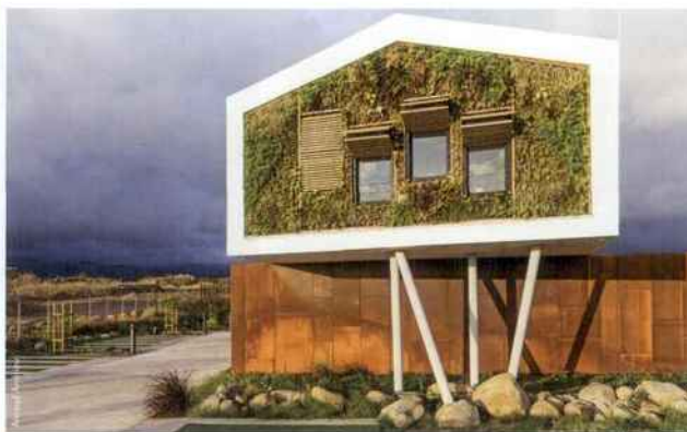
Exposée au soleil et au bruit, la façade ouest s'en protège par la végétalisation.
