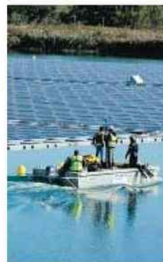
Des techniciens travaillent sur les panneaux de la centrale solaire flottante O'Mega1 de Piolenc, dans le Vaucluse.
