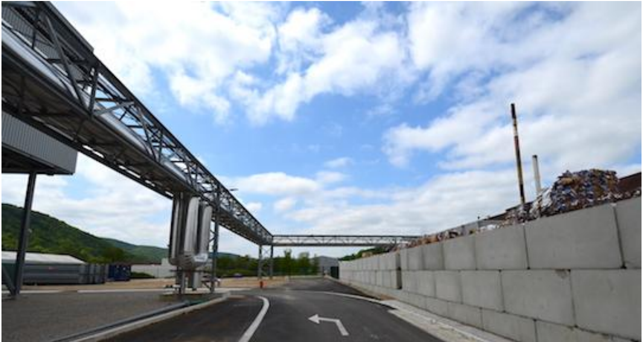
Le réseau vapeur de BCN vers Gemdoub, photo Frédéric Douard
