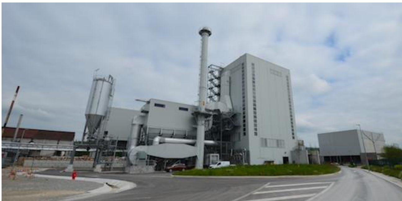
La partie production d'énergie de la centrale, avec à gauche le silo à cendres volantes et à droite le bâtiment-silo, photo Frédéric Douard
