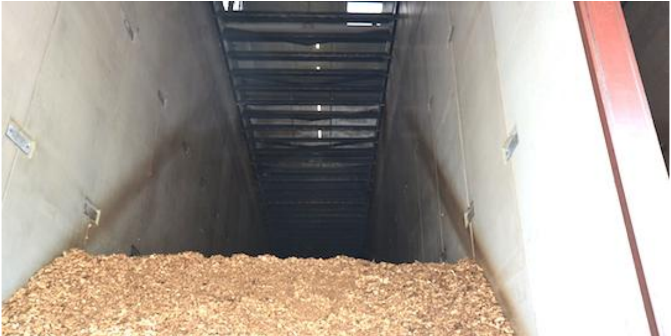
L'une des cellules de stockage de bois avec herse VECOPLAN, photo Frédéric Douard
