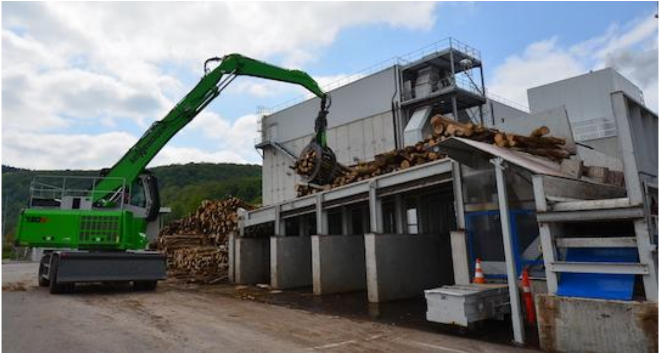
Le deck de déchargement du bois rond, fourni par TBM VECOPLAN, photo Frédéric Douard
