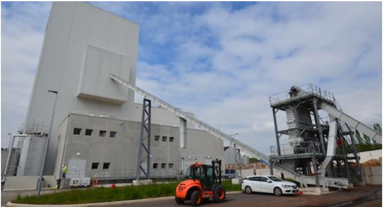
Convoyeur de bois VECOPLAN en aval du crible vers la chaudière, photo Frédéric Douard
