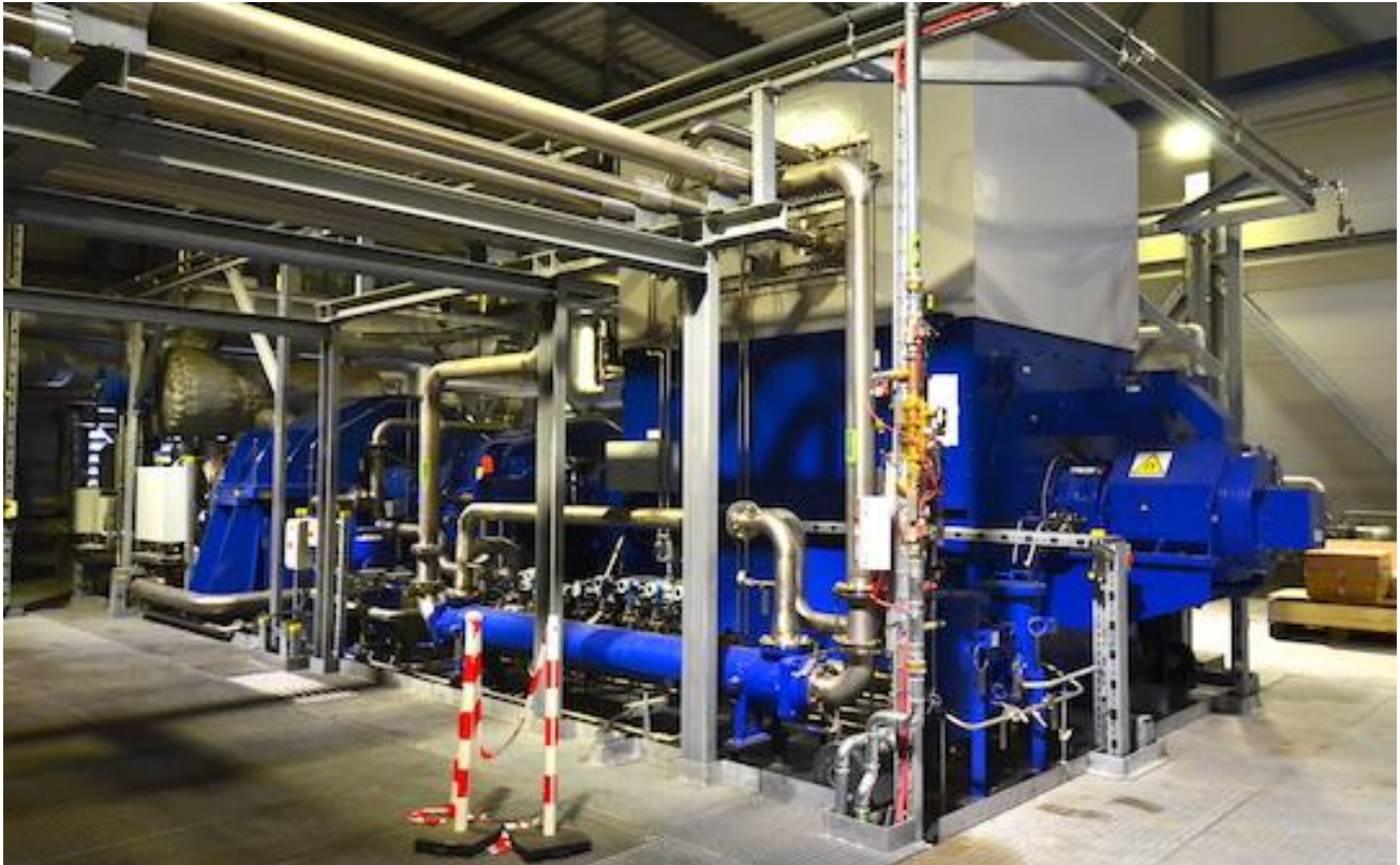
Le turbo-alternateur 20 MWé de BCN, photo Frédéric Douard
