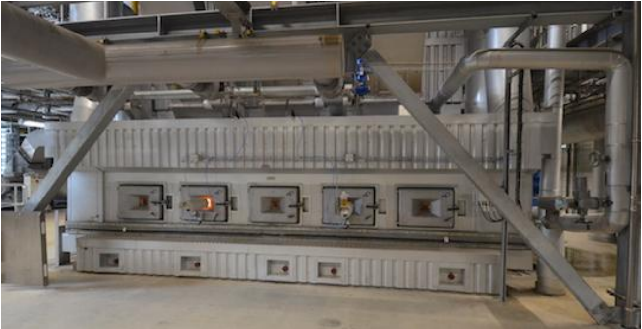
Portes de surveillance de la grille tournante AET, photo Frédéric Douard
