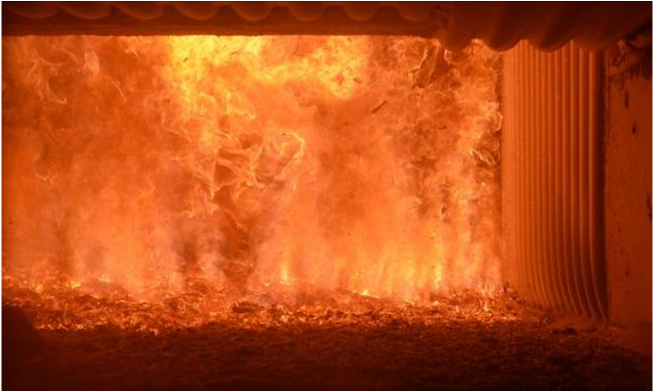
Zone de gazéification du bois sur la grille tournante AET, photo Frédéric Douard
