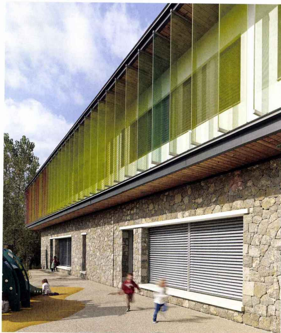
Groupe scolaire Daniel-Pennac, à La-Colle-sur-Loup (Alpes-Maritimes): protection solaire par panneaux de verre colorés et brise-soleil à lames orientables.
