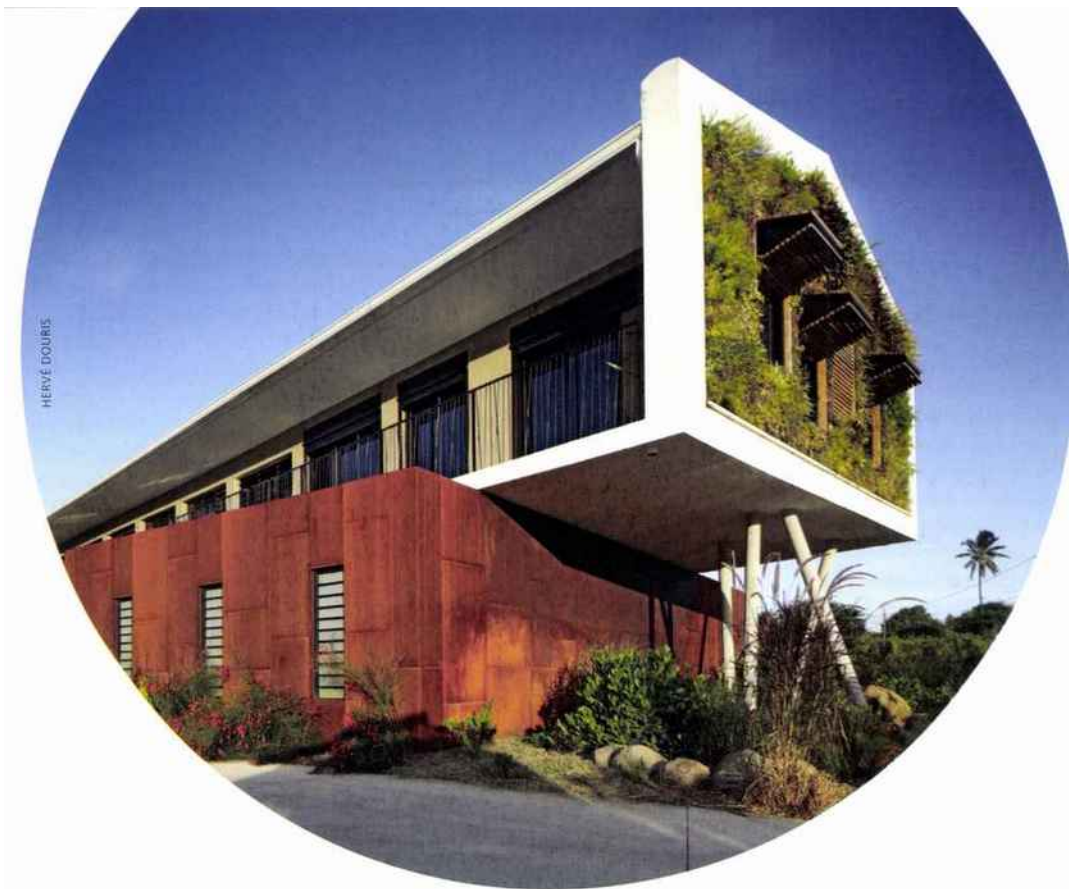
Siège social d'Akuo Energy, à La Réunion: utilisation de la végétation pour réduire la température environnante. (Altitude 80 architecture).
