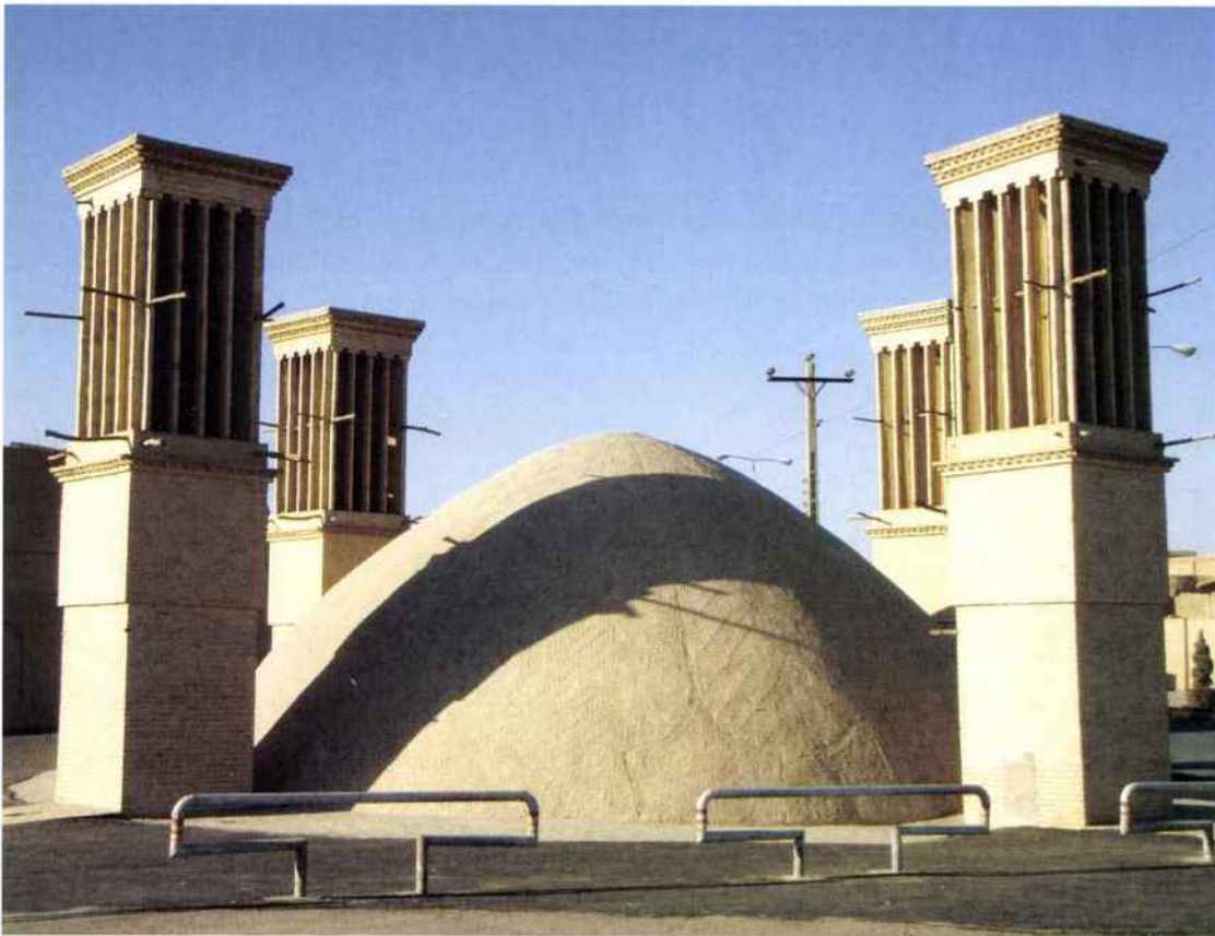
Réservoir d'eau réfrigéré par des badguirs, ou tours à vent en Iran.
