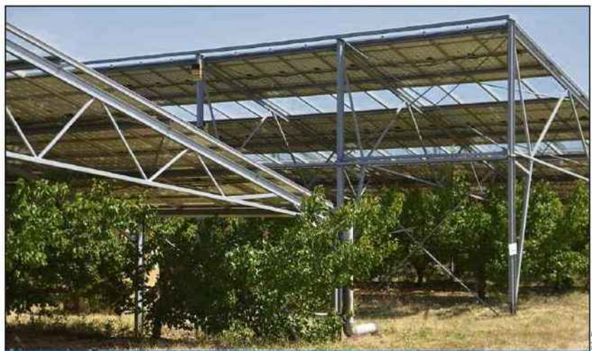
À Bellegarde, le projet Agrienergie (Akuo Energy) comprend 1,5 ha d'abricotiers bio, avec des ombrières de 13 m de largeur, 180 m de longueur, 6 m de hauteur et 2 m de hauteur côté sud. D'autres panneaux, avec une seule bande de lumière, pour un soleil entrant toute la journée sur cerisiers (partie haute), couvrent 3,5 ha.
